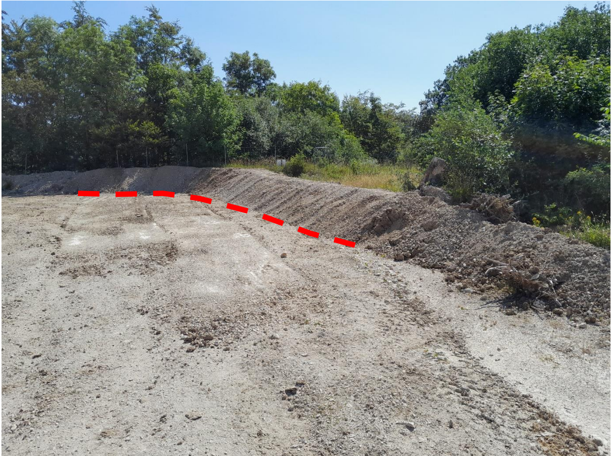
Abb. 3-2 Foto des neuen Walles, Blickrichtung Ost
