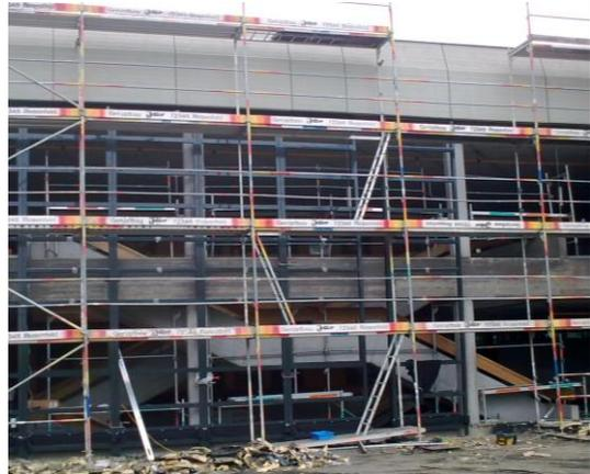
Um den Wärmeenergieverlust über die Gebäudehülle zu reduzieren, wurde auf einer Fläche von 600 m<sup>2</sup> eine jeweils 20 cm dicke Wärmedämmung auf die auskragenden, nach unten an die Außenluft angrenzenden Decken aufgebracht.
