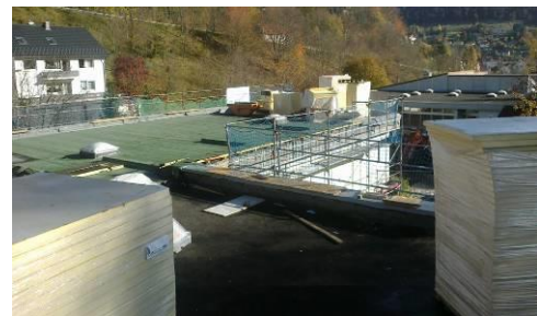
Wärmedämmung Dach
