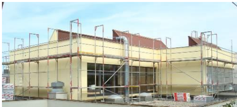
Wärmedämmung Fassade
