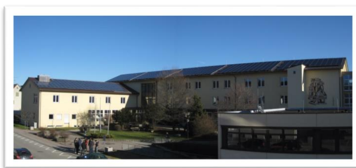
Gewerbliche Schule Balingen kurz vor der Generalsanierung
